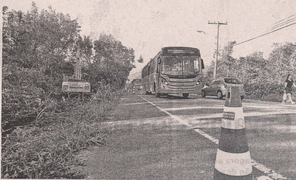
Pista dupla. Máquina retira vegetação ao lado da avenida Diomício Freitas, que ganhará mais uma pista do trevo da Seta até o bairro Carianos
