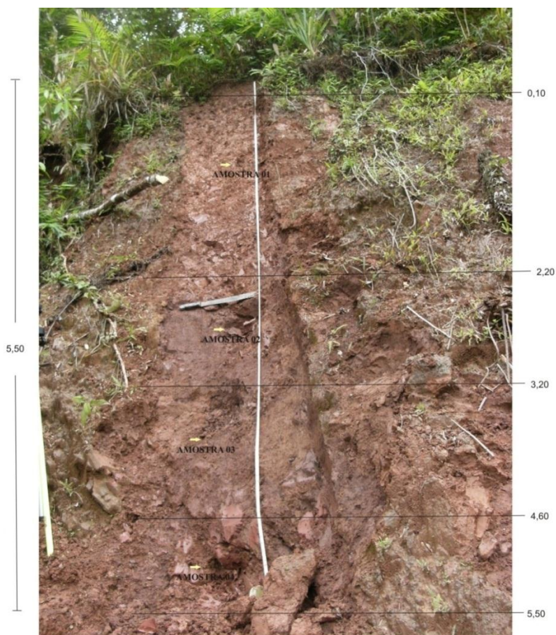
Foto 36 – Local do estudo de detalhe (Perfil 02), localizado em um escorregamento no bairro Belchior Baixo, Gaspar/SC. Fonte: Bini, Mar./2011.
