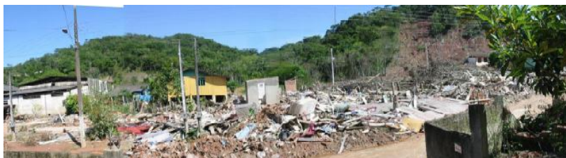
Foto 34 - Residências destruídas pelo fluxo de detrito e de lama consequentes da gerada por dois escorregamentos das vertentes que atuam como área de contribuição do vale. Localizadas no Bairro Sertão Verde, Gaspar/SC. Foto: Pellerin Jan./2009.
