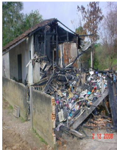
Foto 31 - Casa destruída com o impacto da explosão do gasoduto. Foto: Fonte: Prefeitura Municipal de Gaspar, Dez/2008.
