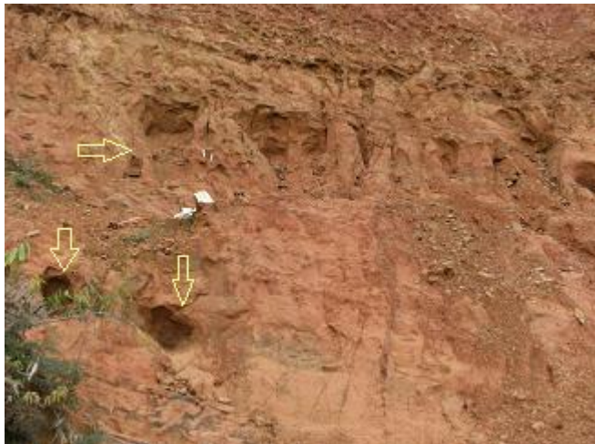
Foto 25 - As setas indicam as feições de alcovas de regressão na parede da encosta situada a Rua Diogo T. Pereira no Bairro Margem Esquerda situado na microbacia do Rio Sertão. Foto: Bini, Abr./ 2010.
