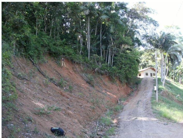
Foto 23 - Escorregamento rotacional no modelado em outeiro com rebaixamento em direção a planície aluvionar, situado a Rua André Schimitt. Foto: Bini, Set./2010.
