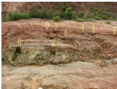
Foto - 26: As setas indicam as nascentes após o escorregamento de novembro de 2008 em manto de alteração das rochas do Grupo Itajaí. Microbacia do Rio Belchior Baixo. Foto: Bini Fev. 2010.
