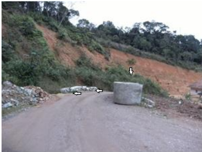
Foto 17 - Sacos de areia e as manilhas para contenção de movimentos de massa no Bairro Margem Esquerda. Fonte: Graziela Bini, Set./2010.
