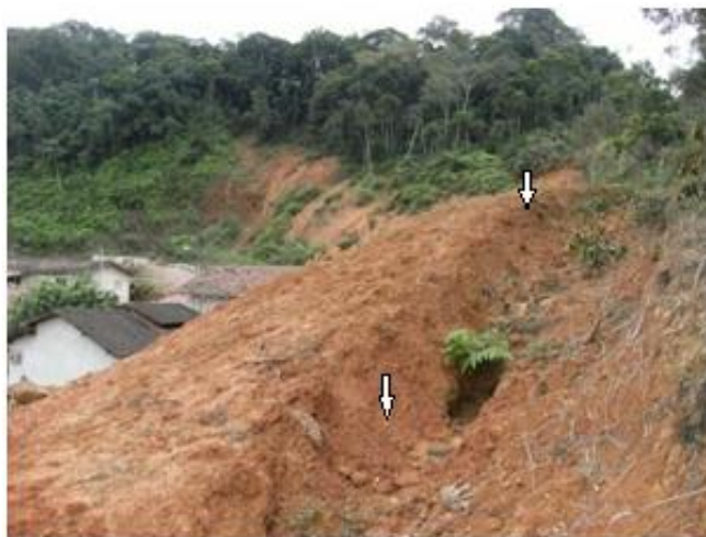
Foto 18 - Em primeiro plano observa-se o dreno para desviar águas pluviais no Bairro Margem Esquerda. Fonte: Graziela Bini, Set./2010.
