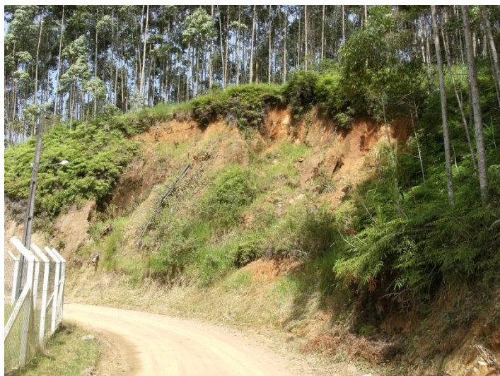
Foto 28 - Escorregamento ocorrido em novembro de 2008 no alto vale do rio Saltinho, bairro Belchior Baixo. O movimento foi provocado, entre outras condicionantes, pelo aumento da declividade resultante das obras de corte de talude. Fonte: Bini, set. /2010.
