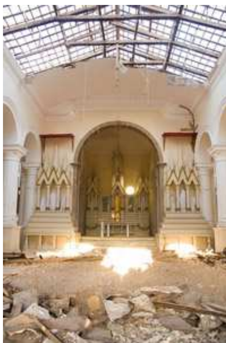
Figura 11. Desabamento do forro da Igreja matriz da cidade de Assu/RN. Fonte: www.nominuto.com .
