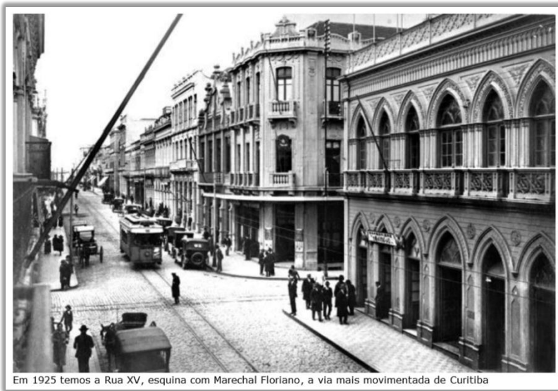
Em 1925 temos a Rua XV, esquina com Marechal Floriano, a via mais movimentada de Curitiba
