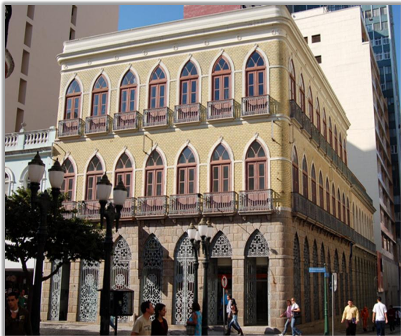
FIGURA 25 – Casa do comerciante Manuel da Costa Cunha Fonte: Foto CROCETTI, 2010. Edificação de 1883 em estilo (arabesco) com influência mouresca, com trabalhos em cantaria e ladrilhos portugueses. Foi projetada por Ernesto Guaita, para Manoel da Costa Cunha para Loja e residência do comerciante, vendido para o ervateiro Manoel de Macedo e confiscado pelos federalistas. Tornou-se agencia e museu do Banestado, e transferido para o banco Itaú em 1998.
