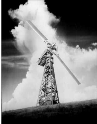
Figura 2.4: Primeira turbina de megawatts construída nos EUA em 1941. Fonte: www.wind-works.org/photos/Smith-PutnamPhotos.html . Acesso em 01/03/2010.
