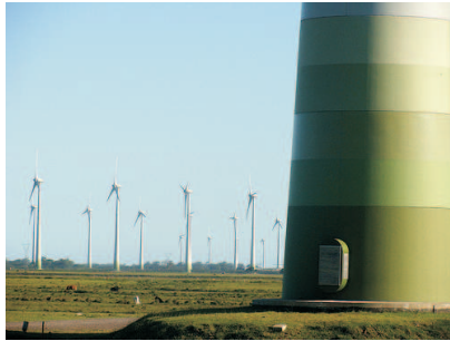
(a) Parque Eólico onshore em Osório, RS.
