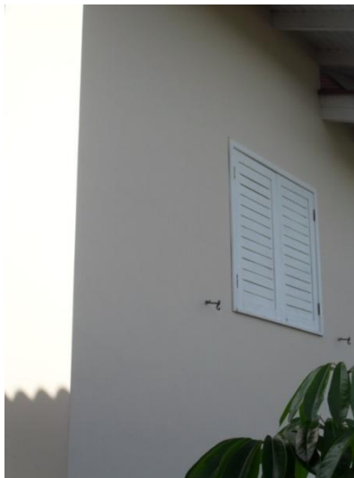
Figura 34: Parede sem fissuras mapeadas (Sol)
