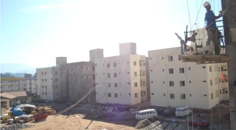
Figura 65: Vista geral do empreendimento em execução AGJ
