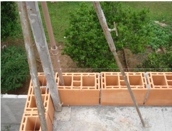
Figura 11: Assentamento primeira fiada
