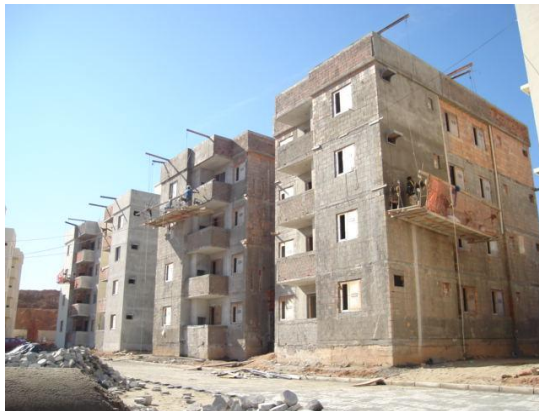
Figura 63: Blocos AGJ em revestimento externo
