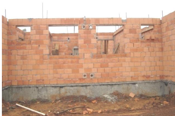
Figura 60: Bloco VNC na fiada de respaldo
