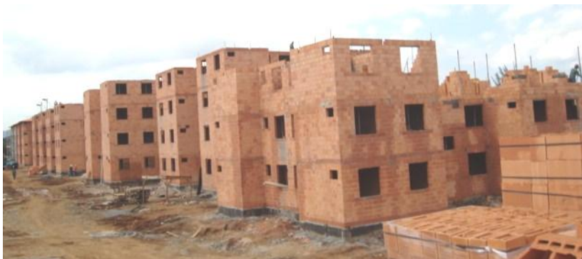
Figura 62: Vista geral do empreendimento em execução VNC
