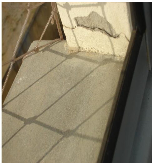
Figura 50: Destacamento na região do vórtice
