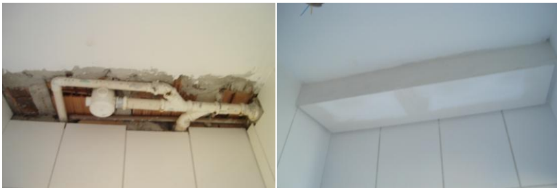
Figura 3: Detalhe de shaft em obra
