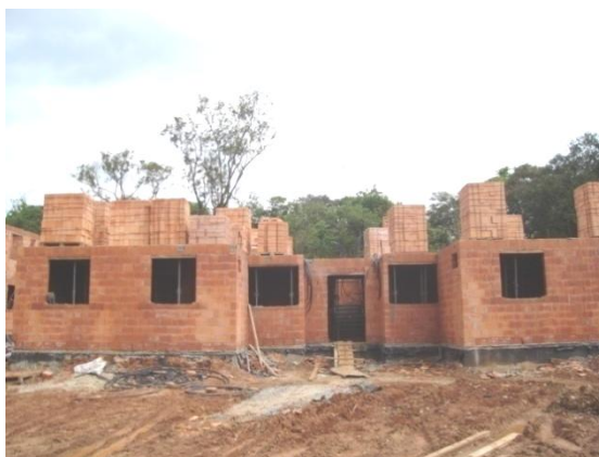
Figura 61: Bloco VNC na marcação da alvenaria
