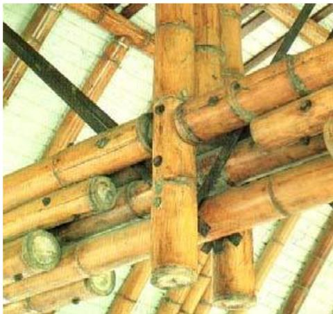
**Figura 38** - Conexões das peças de bambu.
