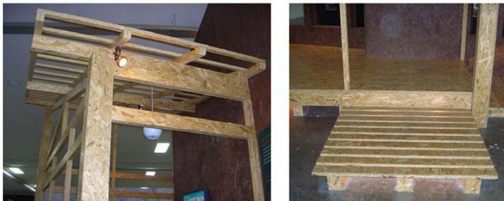
**Figura 34** - Estrutura para casas em OSB de bambu.
