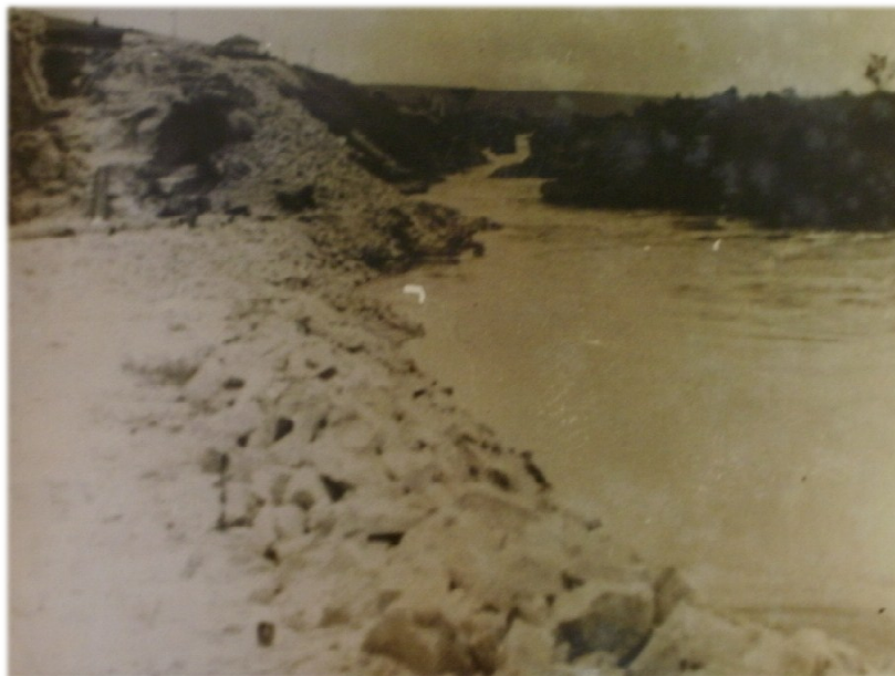
FIGURA 34. Início das construções da Usina de Caiacanga
