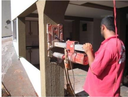
**Figura 1.1 – Extração de testemunho**
