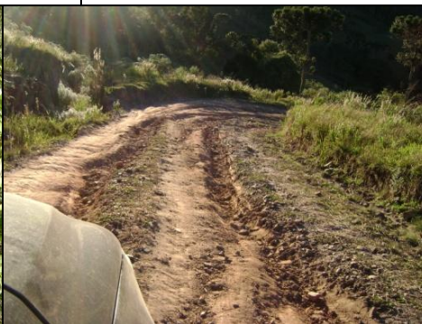
Figura 40 - Estrada precária de acesso a Cascata Avencal.
