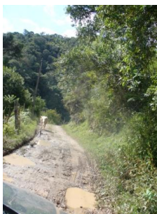
Figura 107 - Estrada precária para a Cascata Avencal.
