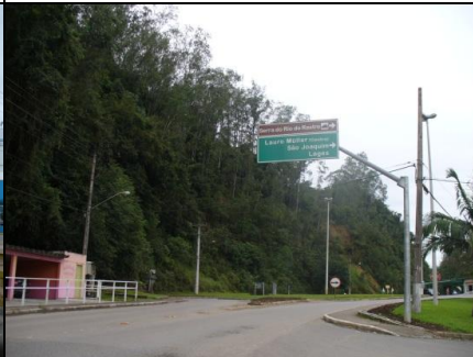
Figura 86 – Trevo de acesso à Lauro Muller. Fonte: Autora, 17/03/2011
