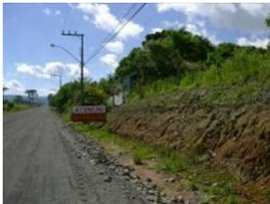
Figura 105 – Trajeto SC 439 sendo pavimentado.
