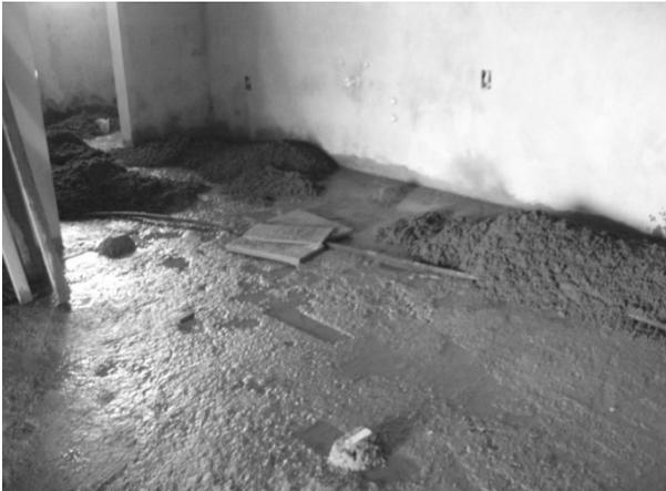
**FIGURA 25** – Proteção de madeira para a canalização.
