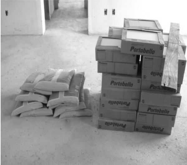
**FIGURA 3** - Estoque do andar de argamassa colante e cerâmica.
