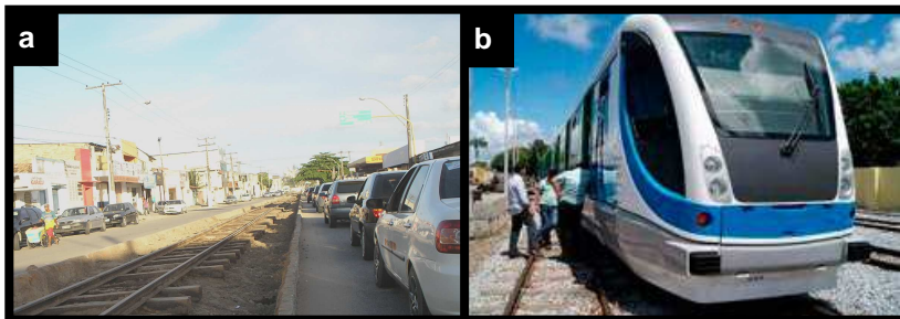
Figura 3.5: Obras da fase inicial para implantação do VLT na Rua Buarque de Macedo, Centro; b) Composição do VLT no pátio da estação Maceió, Centro.
