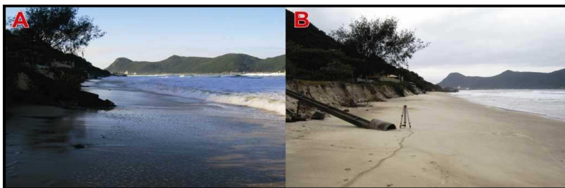
Foto 11: A) Vista para o norte da praia da Solidão, observando-se a invasão da pós-praia pelo ação marinha e a queda do poste que serviu de marco para a medição do perfil (Foto de Caio Heidrich, maio de 2010). B) Vista para o norte da praia da Solidão, um mês após as ressacas de abril e maio de 2010 que afetaram a praia, retratando o recuo do mar e a pós-praia emerso novamente (Foto de Caio Heidrich, junho de 2010).
