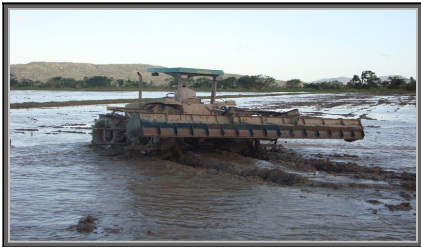
Imagem 8: Nivelamento do terreno.
