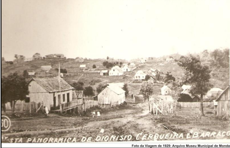
Figura 22 - Vista Parcial de Dionísio Cerqueira e Barracón em 1929
