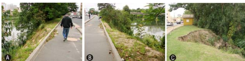
Figura 85 – Pontos de erosão. Fotos: E. Guimarães, 2010.
