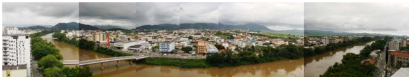
Figura 57 – Margem esquerda da cidade. À esquerda da foto as duas pontes que cruzam a área central, respectivamente, da extremidade para o centro, a ponte Nereu Ramos/Heriberto Hülse e a ponte Dilney Chaves Cabral. Foto: E. Guimarães, 2010.
