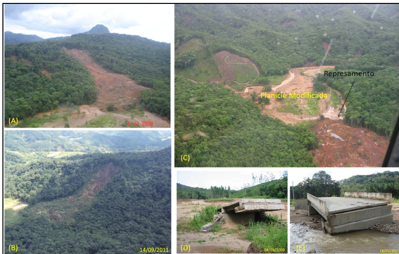
Figura 82: Escorregamento com represamento do curso d' água e modificação da planície de inundação (UTM 705627/7030824). (A) Vista geral do escorregamento (dez de 2008); (B) Vista geral do escorregamento em sucessão ecológica da vegetação (outubro de 2011); (C) Planície modificada pelo represamento da massa deslizada; (D) Ponte destruída em 2008; e (E) Ponte reconstruída no mesmo local e destruída em janeiro de 2011. Fotos: A e E: autor; Fotos B, C e D: Joel Pellerin.
