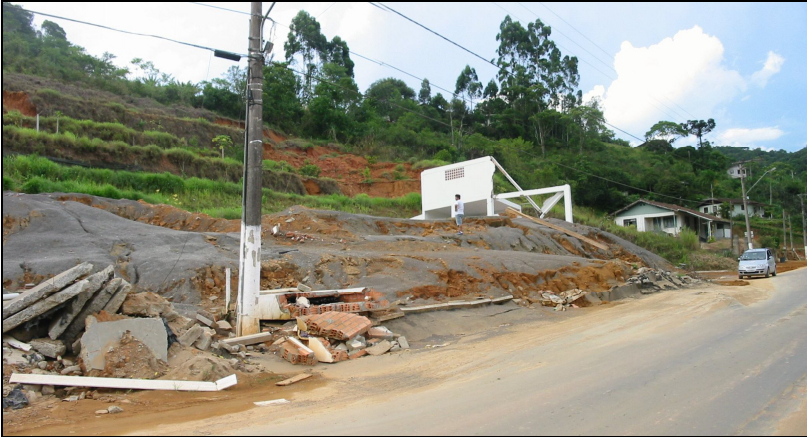
Figura 12: “Embarrigamento da base da encosta”. Posto de Gasolina em Blumenau. Foto: Joel Pellerin, Janeiro de 2009.
