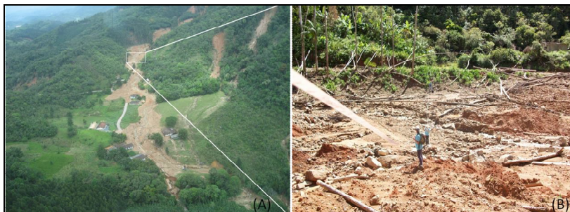
Figura 89: Detalhe da passagem do fluxo (A) Grande fluxo de detritos advindo da Tifa dos Rincos destruindo várias residências. (B) Medida de 53m da largura da passagem do fluxo no vale principal da Tifa dos Rincos. Fotos: Joel Pellerin (jan, 2009)
