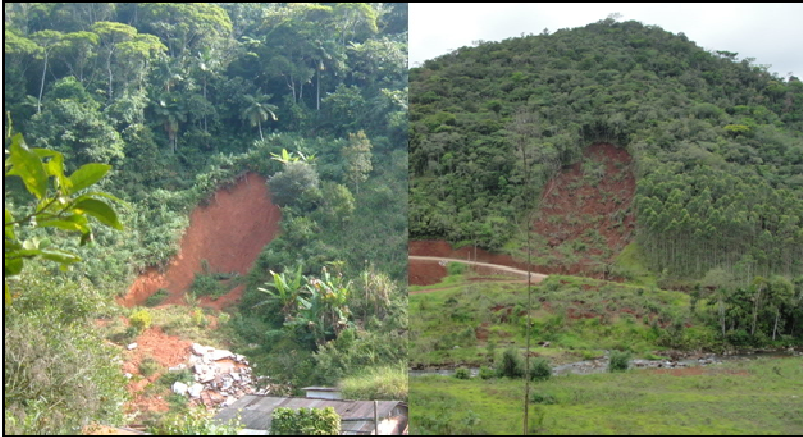
Figura 14: Escorregamentos do tipo translacional espesso. A foto da esquerda (foto: junho de 2009) é um deslizamento ocorrido no manto de alteração de pelitos na Rua União da Vitória, Bairro Valparaíso, Blumenau, SC, com a destruição de uma casa sem vítimas. A imagem da direita (foto: 16/11/2010) demonstra um deslizamento ocorrido no espesso manto de alteração do Complexo Luiz Alves (granulitos) Morro Azul (Braço do Baú) Ilhota, SC, onde foi destruída uma residência provocando o óbito de uma família inteira e provocando o represamento temporário da drenagem. Observou-se relatos de pipings antes do colapso do escorregamento na base da encosta. Os dois deslizamentos ocorreram em novembro de 2008. Fotos: autor.
