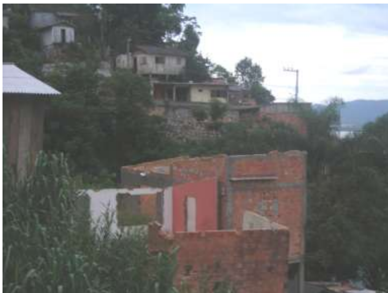
Figura 106 – Demolições não concluídas das na Caieira Acervo da autora – Fevereiro/2011
