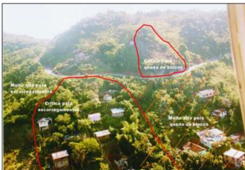
Figura 42 - Setorização - Alto da Caieira - suscetibilidade a escorregamentos e queda de blocos
