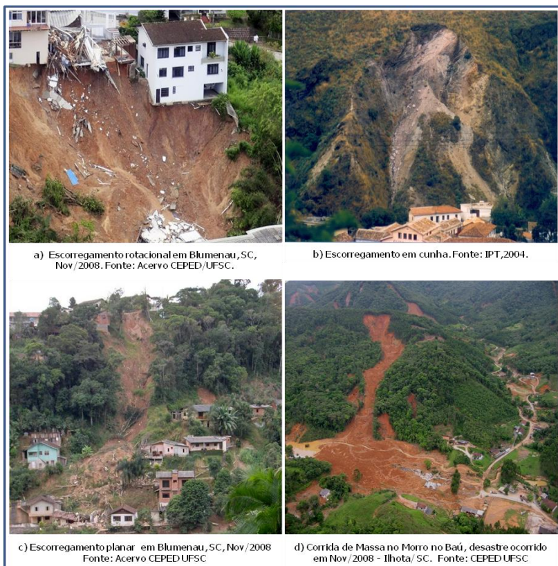
Figura 8: Processos de Escorregamentos em Encosta.
