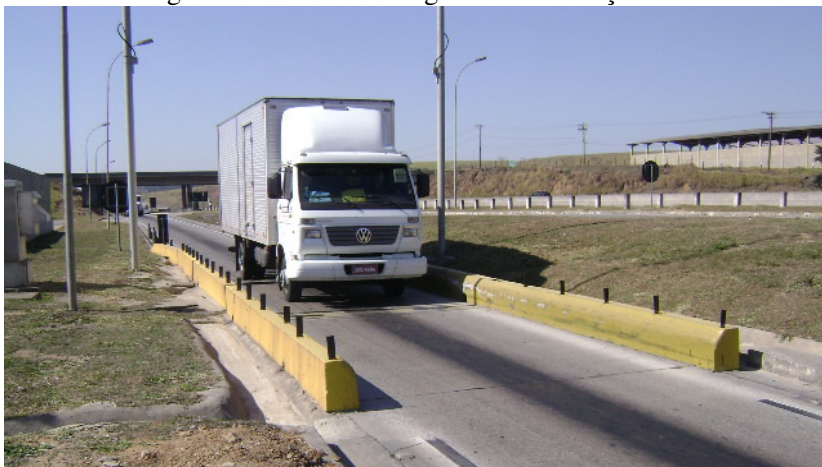
Figura 3.12 Detalhe da balança seletiva
