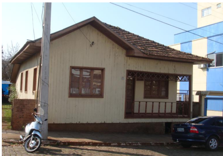
Figura 12 - Casa de Madeira localizada no Centro de Marau
