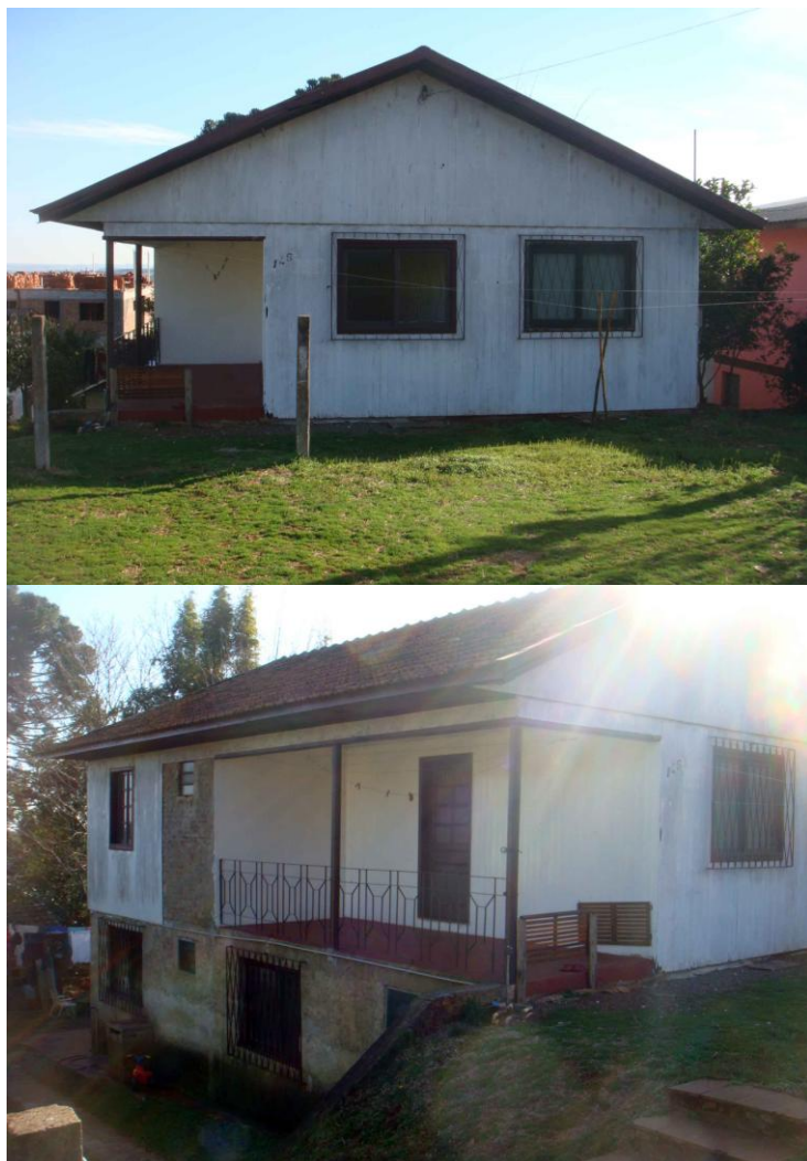
Figura 6 - Casa de Madeira em Regular Estado de Conservação
