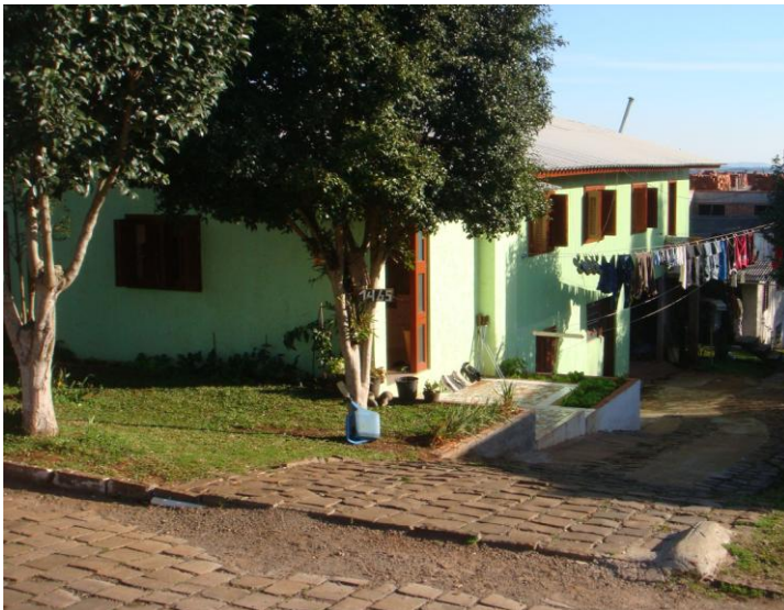
Figura 9 - Casa de Alvenaria Localizada no Bairro Vicente Riva
