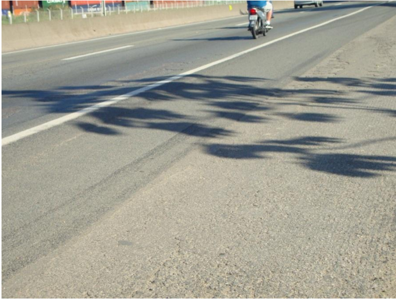
Figura 21 - Massa asfáltica na lateral da pista de rolamento Fonte: foto tirada pela autora da dissertação.
