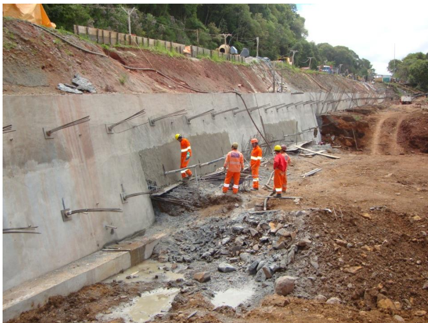
Figura 26 - Muro de contenção de encostas na BR-116/SC
