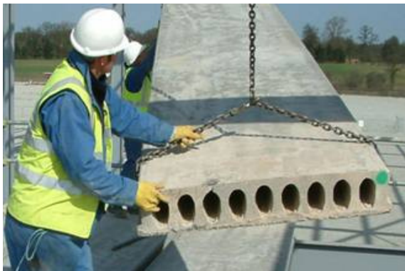
Figura 2-3 – Montagem da laje alveolar
