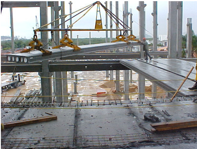
Figura 2-9 – Montagem dos PACP
