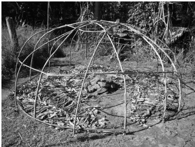
Foto 64 Estrutura para temazcal na Pedra Branca
