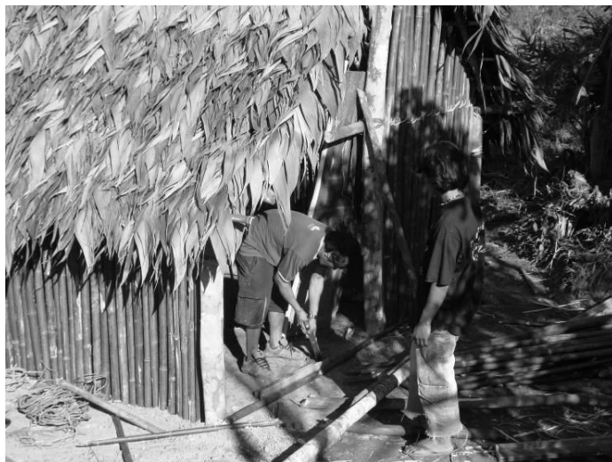
Foto 63 Construção da opy da Pedra Branca
