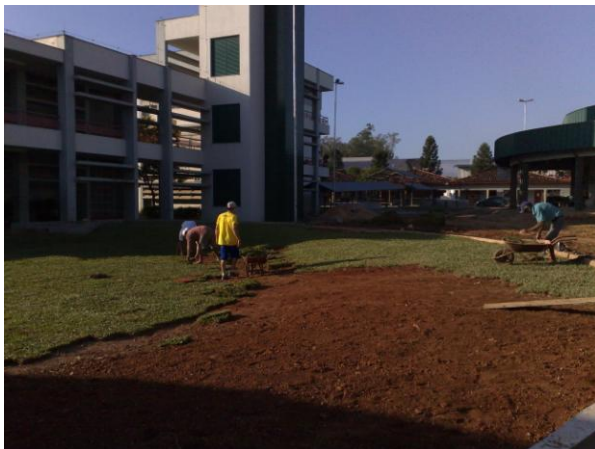
Fig. 09: Obra na Praça do Estudante. (2009).
