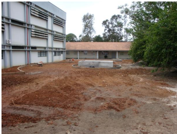
Fig. 06: Praça “P/Z”: início da obra. (2008).
