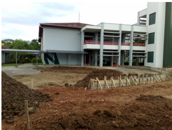
Fig. 08: Obra na Praça do Estudante. (2009).
