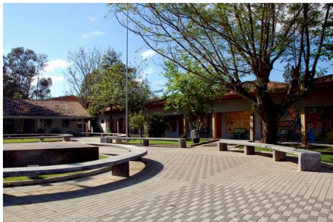
Fig. 23: Piso da Praça "P/Z" (primeira etapa): Blocos de concreto formam desenho xadrez. (2009)
