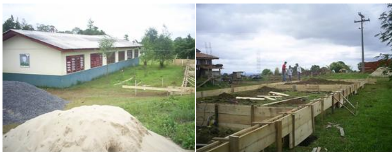
Figura 9: Imagens da escola em momento de ampliação da estrutura física
