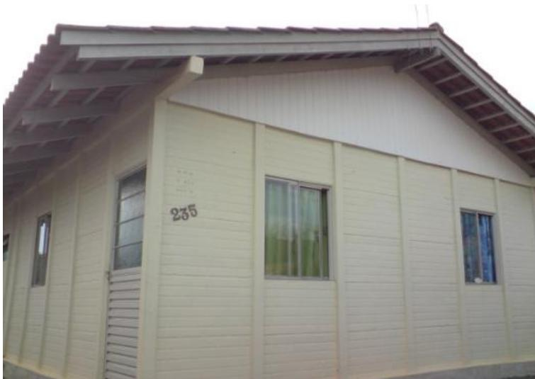
FIGURA 29: Fachada da residência construída em placas pré-moldadas de concreto.
