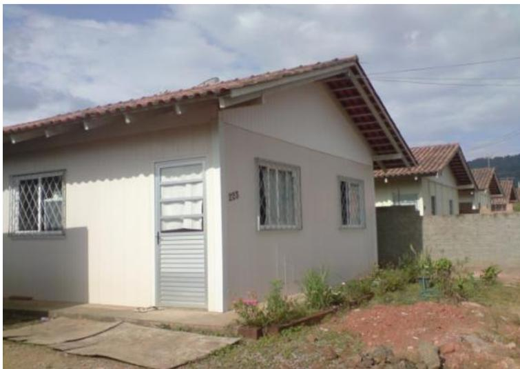
FIGURA 33: Fachada frontal e lateral da residência construída em PVC.
