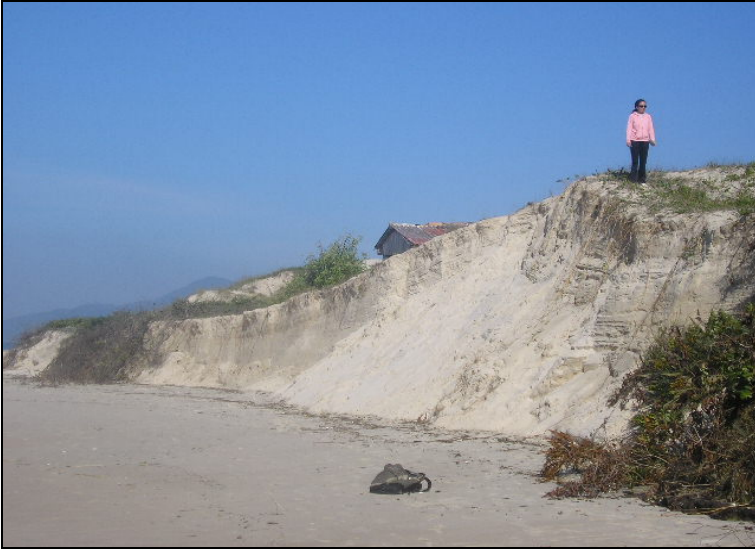
Foto 12. Escarpa na duna frontal na praia do Campeche após o efeito da erosão no inverno de 2008 (Foto de Ulisses Rocha de Oliveira, 2008).
