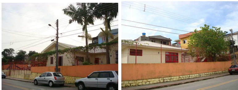
Figura 5. Fachada da Creche, abril/2009.
