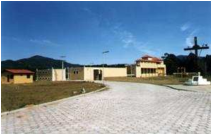
Foto 06: Estação de Tratamento de Água (ETA)
