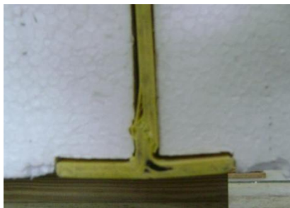
Figura 3.20 – Detalhe da ruptura no perfil do V1
