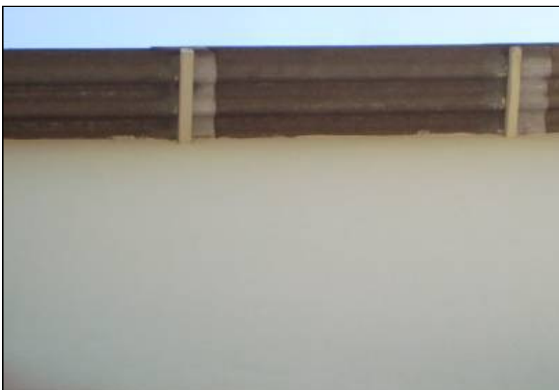
Figura 160 - Vista telhado residencial A13. Fonte: Pesquisa de campo, 2009.
