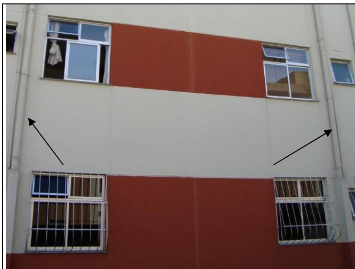
Figura 180 - Tubulações externas do residencial A4. Fonte: Pesquisa de campo, 2009.
