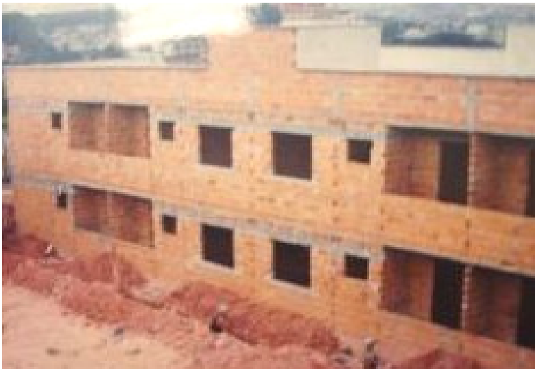
Figura 24 - Detalhe da construção do residencial A15. Fonte: Pesquisa de escritório, 2009.
