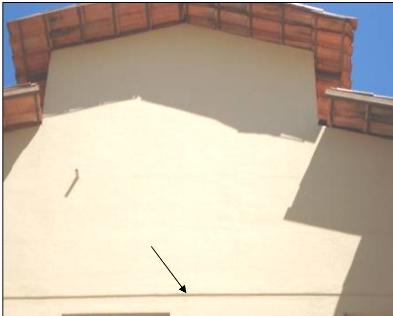
Figura 107 - Telhado residencial A2. Fonte: Pesquisa de campo, 2009.
