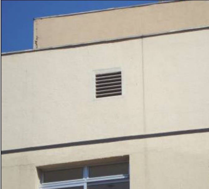
Figura 216 - Vista telhado residencial A11. Fonte: Pesquisa de campo, 2009.
