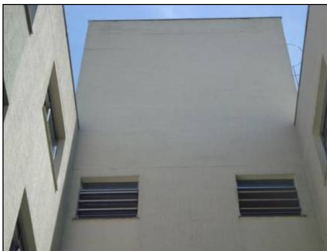
Figura 194 - Telhado embutido residencial A6. Fonte: Pesquisa de campo, 2009.
