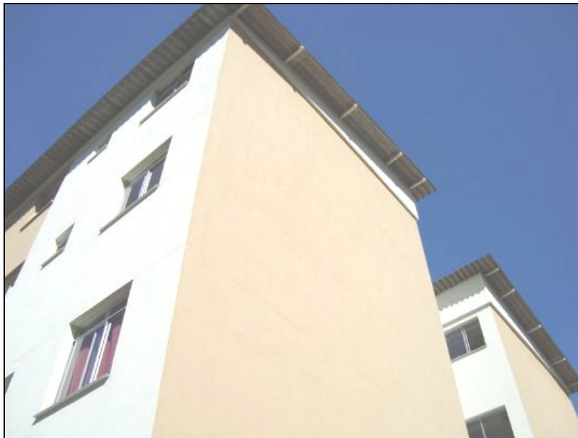
Figura 101 - Telhado residencial A1. Fonte: Pesquisa de campo, 2009.
