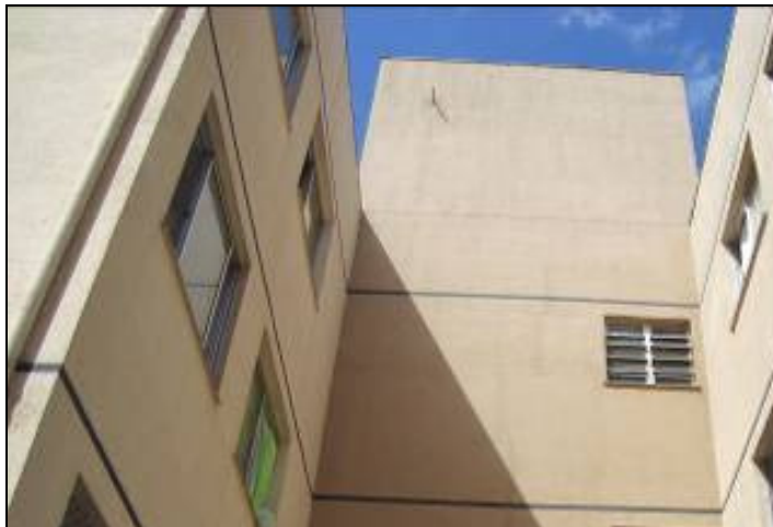
Figura 154 - Vista telhado residencial A12. Fonte: Pesquisa de campo, 2009.
