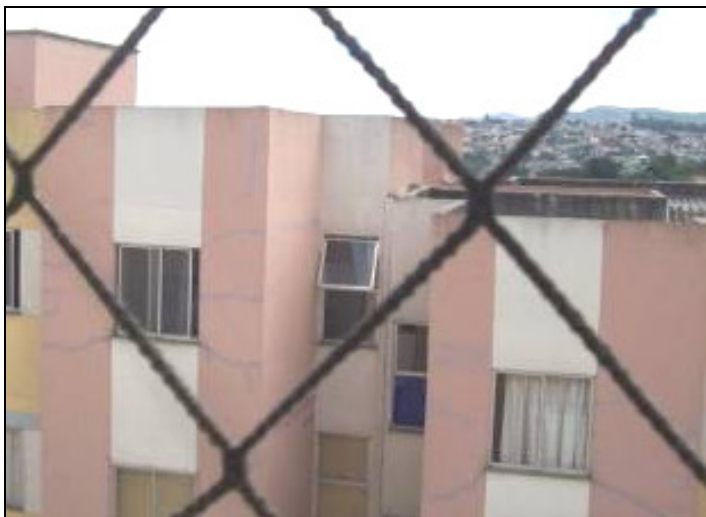
Figura 146 - Vista do telhado do residencial A10. Fonte: Pesquisa de campo, 2009.
