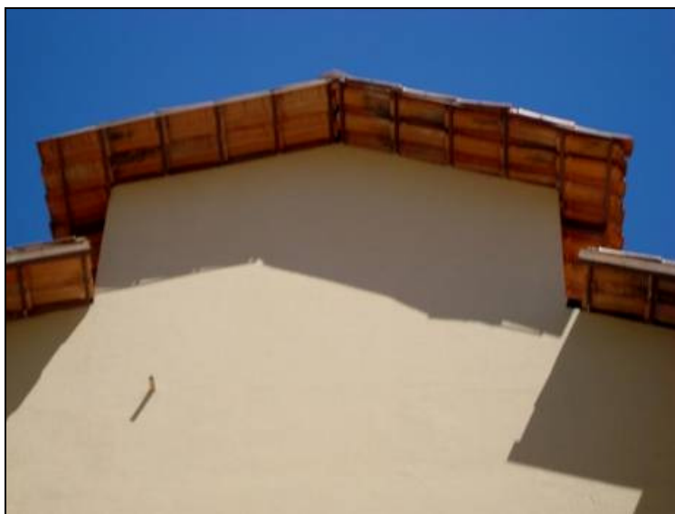
Figura 177 - Telhado residencial A2. Fonte: Pesquisa de campo, 2009.
