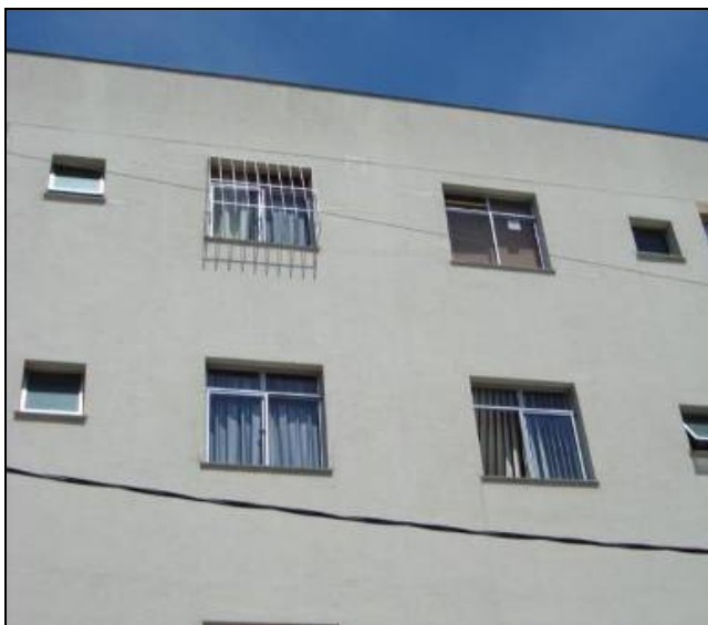
Figura 193 - Telhado embutido residencial A6. Fonte: Pesquisa de campo, 2009.
