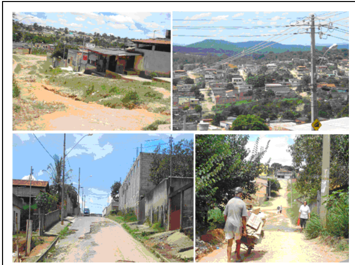
Figura 3.3 – Infra-estrutura - Situação atual.
