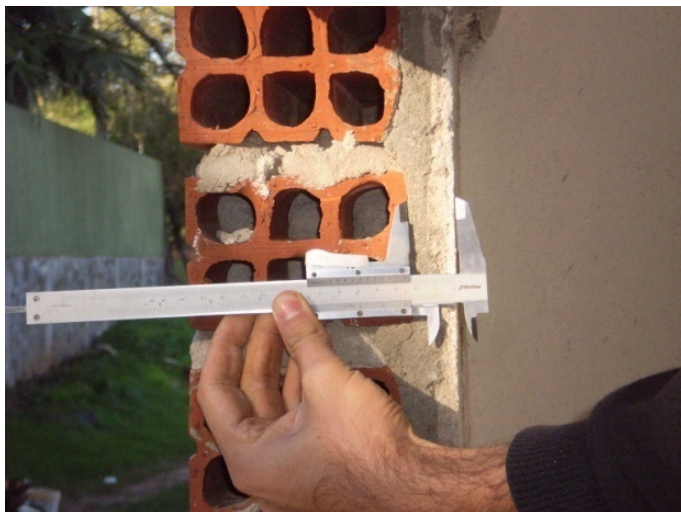
Figura 19 – Medida da espessura do emboço interno nas aberturas
