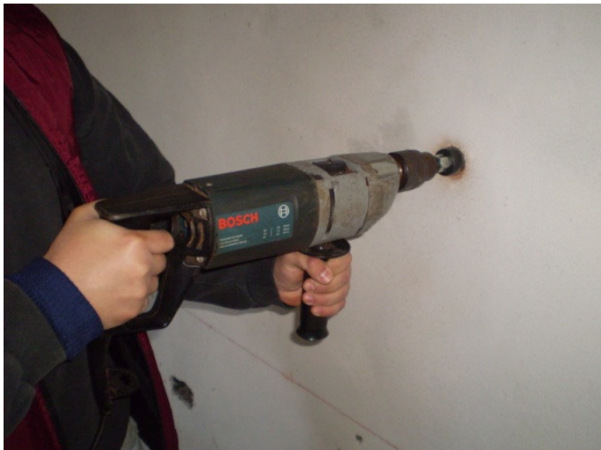
Figura 43 – Investigador realizando as medições da espessura dos revestimentos.
