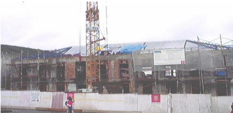
Figura 20: montagem da estrutura da cobertura do novo edifício. Fonte: Labybe Maria, 2005
