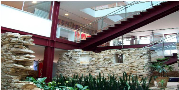
Figura 33: colunas de metal sustentando os pavimentos superiores.2009
