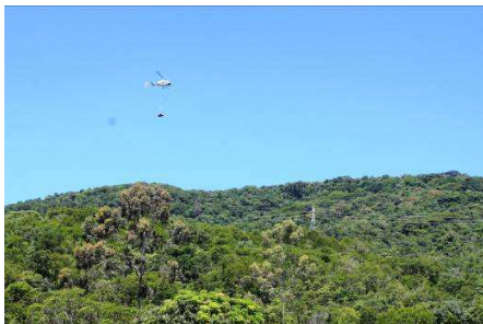
FIGURA 73 - Transporte dos componentes da Linha de Transmissão por helicóptero.
