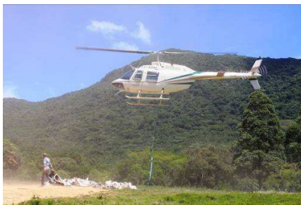
FIGURA 73 - Transporte dos componentes da Linha de Transmissão por helicóptero.
