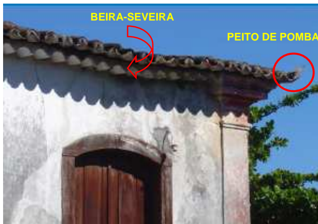
FIGURA 26 - Beira-seveira e terminação do telhado em peito de pomba, em residência na Costeira do Ribeirão.
