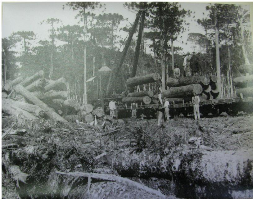
Figura 5 – Guincho da Lumber carregando vagão com toras de araucária. Região de Três Barras. Década de 1910.
