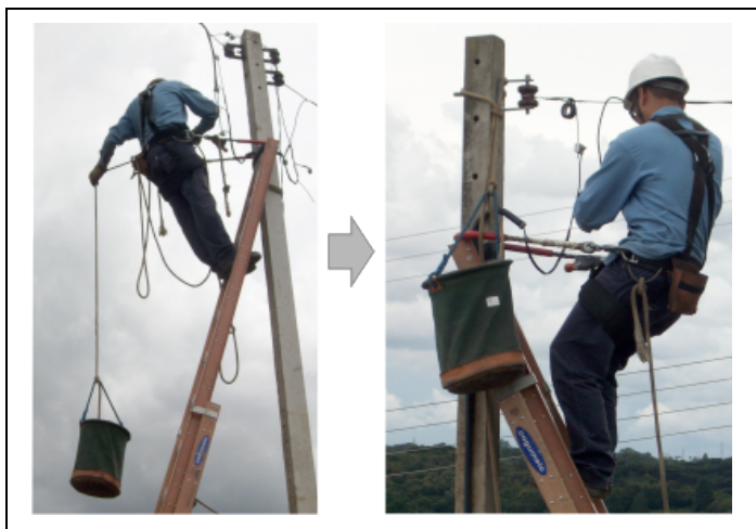
Figura 46: Içamento do balde de lona contendo ferramentas e materiais de trabalho
