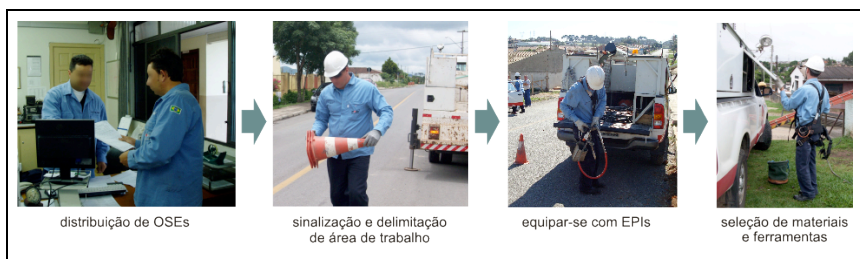
Figura 22: Procedimentos de trabalho realizados pelos eletricitistas
