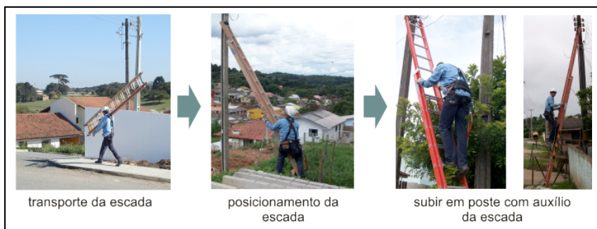
Figura 23: Procedimentos para transportar, posicionar e instalar escada
