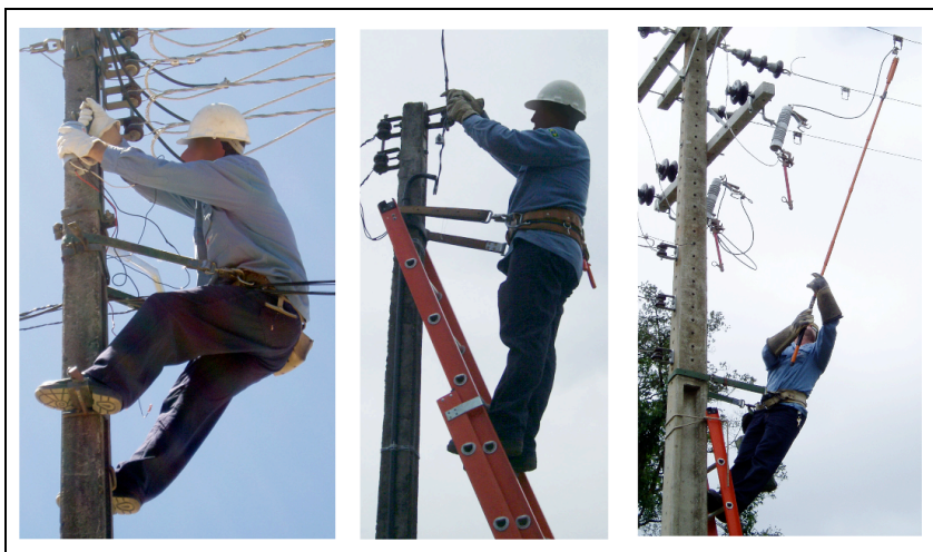
Figura 27: Eletricitistas utilizando o cinto tipo abdominal ao se posicionarem em estrutura
