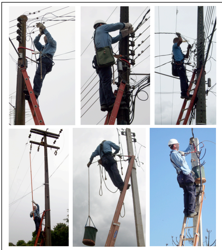
Figura 41: Posturas de trabalho típicas de eletricitistas que atuam em redes aéreas de distribuição de energia
