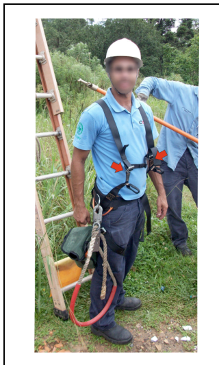
Figura 32: Eletricista utilizando cinto tipo paraquedista modelo B
