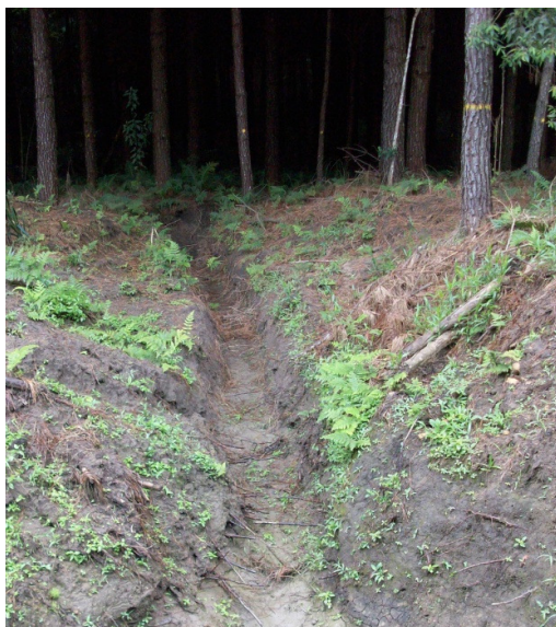
Figura 37 – Detalhe do canal de condução à bacia de acumulação
