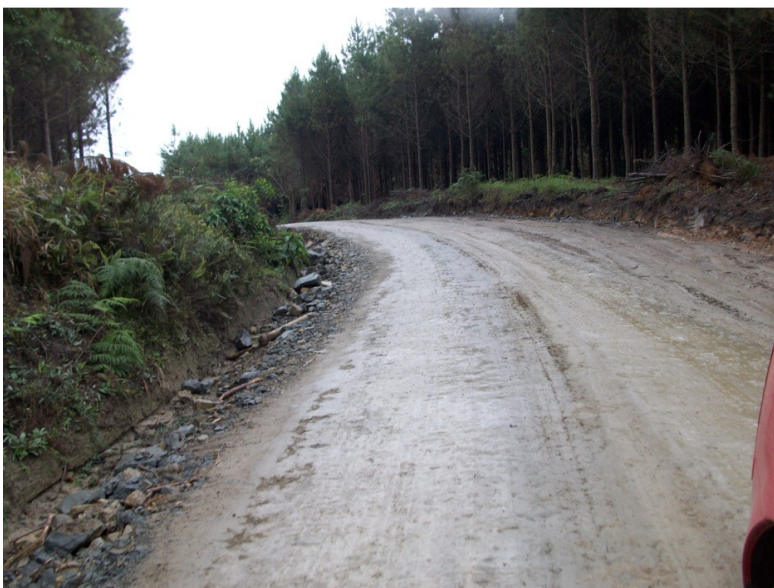
Figura 29 – Foto do canal da estrada da área de estudo
