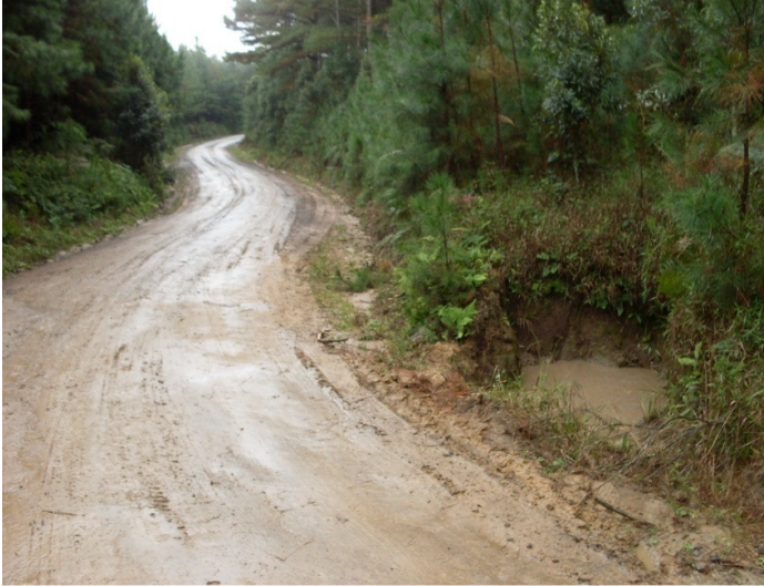
Figura 5 - Caixa de acumulação ou contenção
