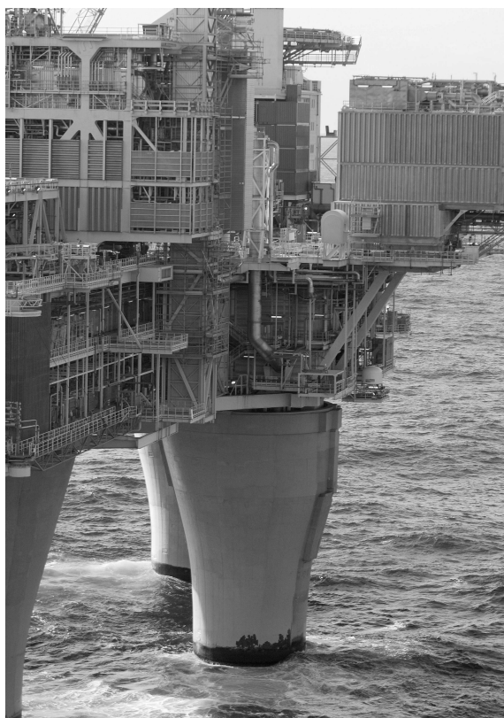
Figura 1.2: Foto da estação inversora na plataforma Troll A.
