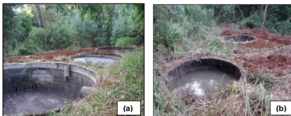
Figura 5: Pontos de recebimento do efluente gerado pela vinícola. (a) Detalhe do Ponto A: efluente do processo produtivo. (b) Detalhe do Ponto B: efluente das operações de lavagem de vasilhames.
