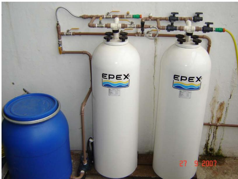
Figura 4: Sistema utilizado na ampliação de escala com CP.
