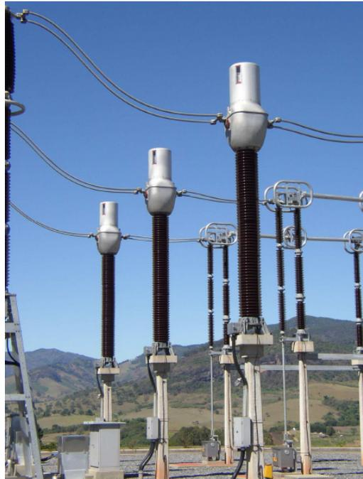
Figura 14 – TC tipo barra fixa de alta tensão (AREVA, 2000)
