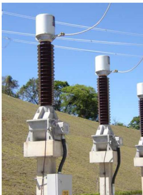
Figura 16 – TP indutivo conectado a uma subestação (AREVA, 2000)
