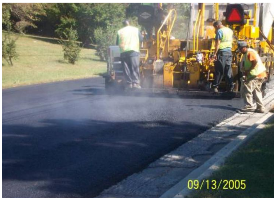
Figura 7 – Execução de superfície de rolamento com adição de Sasobit.
