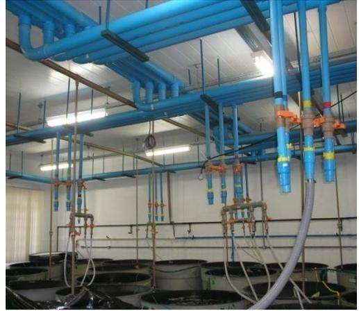
**Figura 10.** Distribuição de água do Sistema de recirculação
