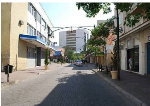
Fig. 3.112 – Vista da 15 de Novembro, com o edifício da Previdência Social à esquerda. Ao fundo, o Banco do Brasil finaliza a perspectiva deste segmento da rua Fonte: Do autor
