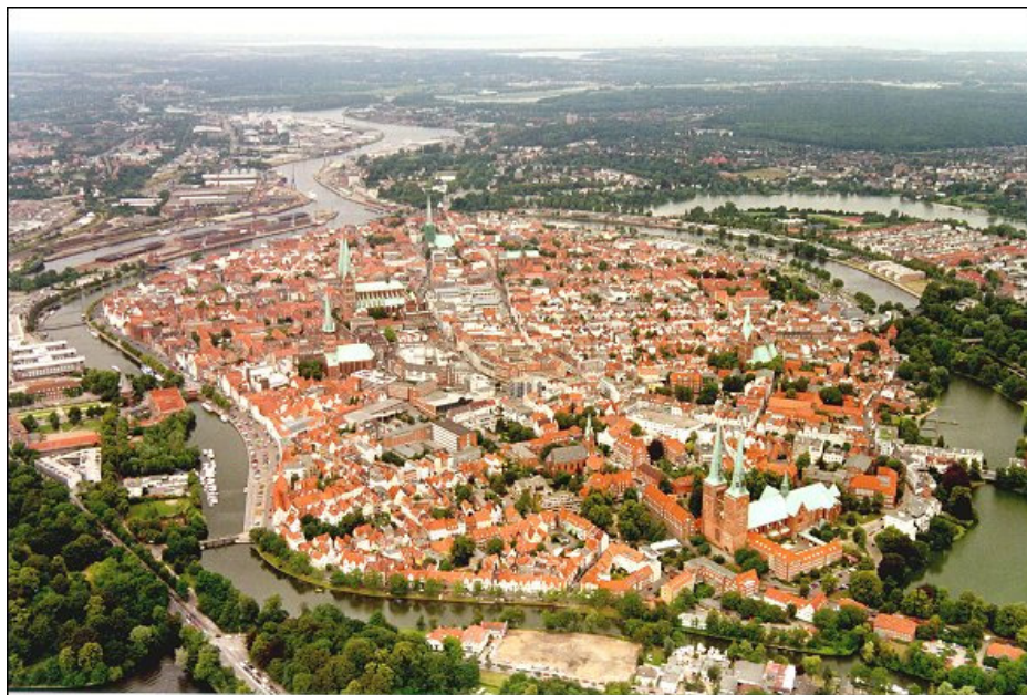
Fig. 2.7 – Vista aérea do centro antigo da cidade de Lübeck, Alemanha Fonte: Google, www.isp.uni-luebeck.de/if104/LI/index.htm
