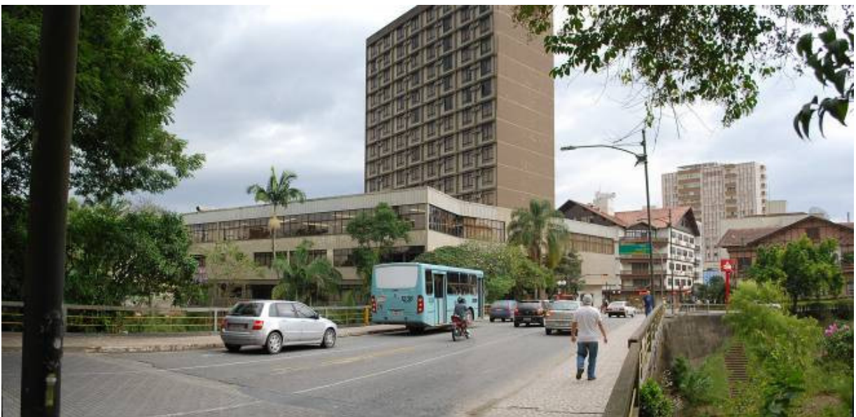
Fig. 3.35 – Vista para o início do trecho B , onde à esquerda está o Grande Hotel Blumenau Fonte: Do autor
