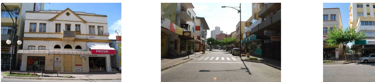
Fig. 3.130 – Vistas da rua 15 de Novembro - a figura da esquerda mostra a antiga Casa Aurora, que está o lado do edifício Brasília, conserva afastamentos laterais que lembram a arquitetura da imigração.
