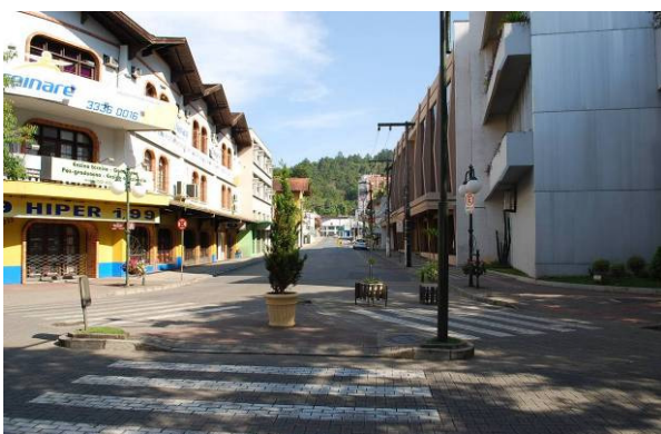
Fig. 3.126 – Vista da Rua Namy Deeke, em que, aparece ao fundo, à direita, o hotel Himmelblau Fonte: Do autor
