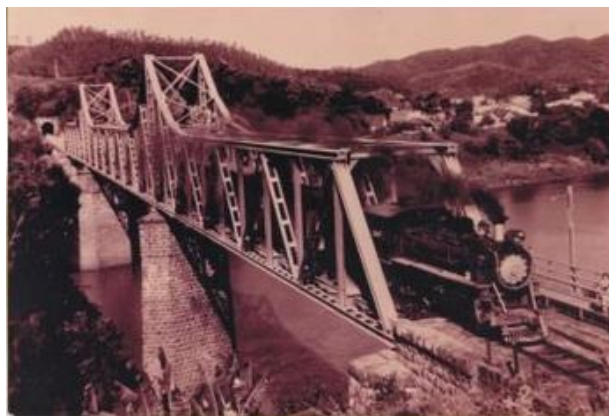
Fig. 2.21 – Ponte de Ferro
