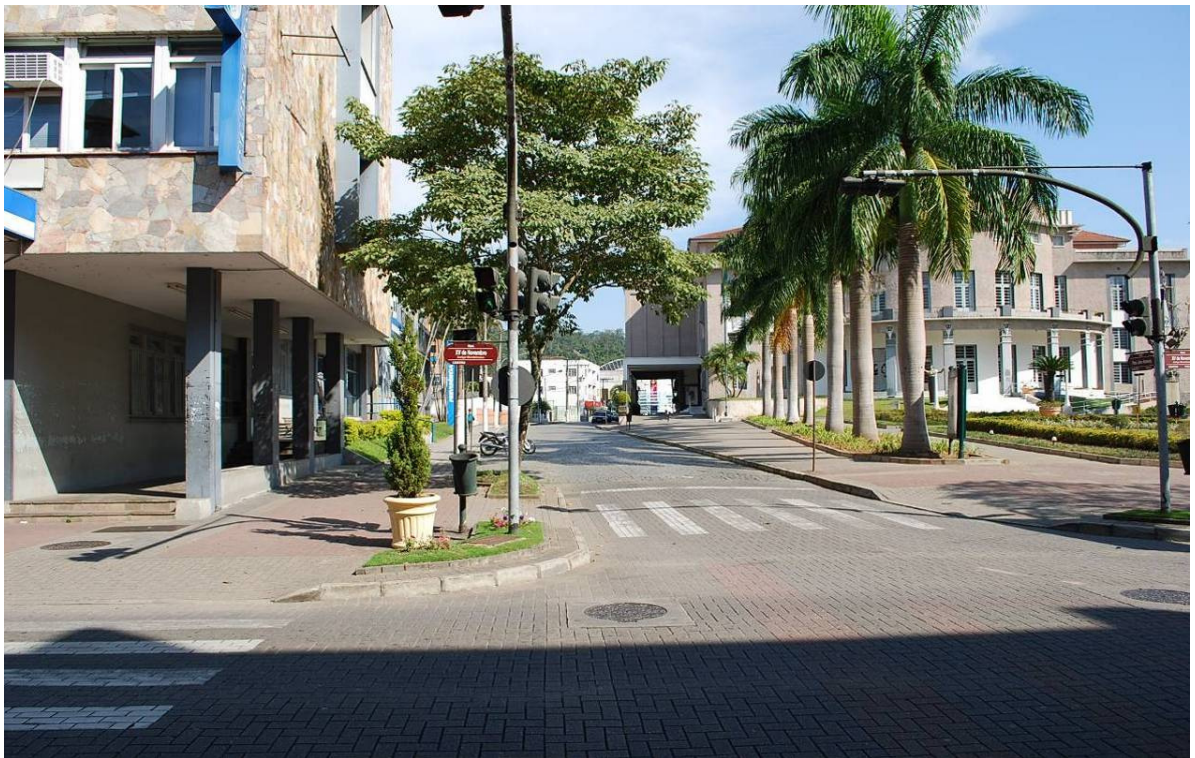
Fig. 3.115 – Vista da rua Presidente John Kennedy, mostra o edifício da Previdência Social com a calçada semi-coberta. Sua colunata dialoga com o ritmo das palmeiras da calçada oposta, e as colunas da entrada do teatro Fonte: Do autor
