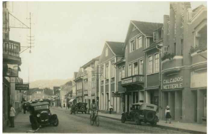
Fig. 2.28 – Vista da Rua 15 de Novembro, 1930-1940 – entre as ruas Floriano Peixoto e Ângelo Dias Fonte: Arquivo Histórico de Blumenau
