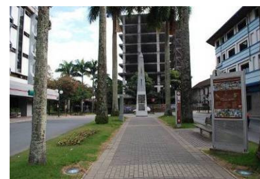
Fig. 3.19 – Vista do edifício América, a partir da rua das Palmeiras Fonte: Do autor
