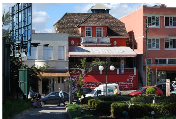
Fig. 3.120 – Vista da antiga Casa Baumgarten Fonte: Do autor
