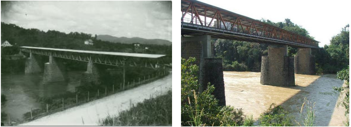
Fig. 2.15 – Ponte do Salto antiga, e atual
