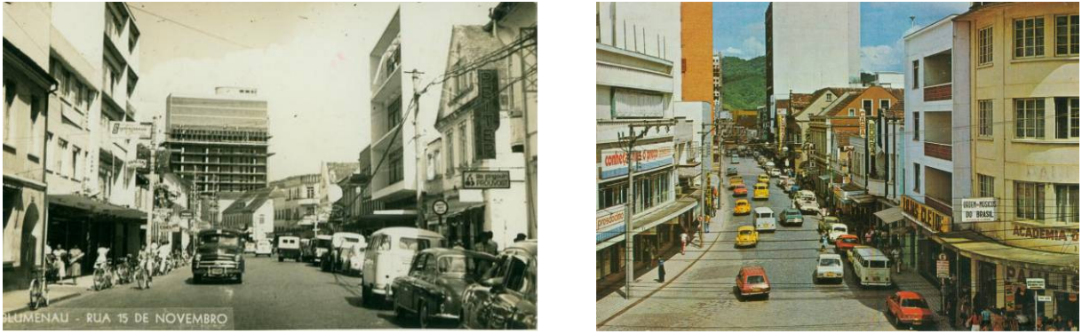
Fig. 2.39 – Vistas da rua 15 de Novembro, 1960-1970 – à esquerda, mostra o edifício da Casa Peiter do lado direito da rua e, ao fundo, o Grande Hotel Blumenau; à direita, vista para o edifício Hering, a partir do mirante de cathedral
