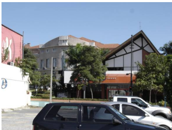
Fig. 3.117 – Banco Itaú, vista da fachada frontal Fonte: Do autor
