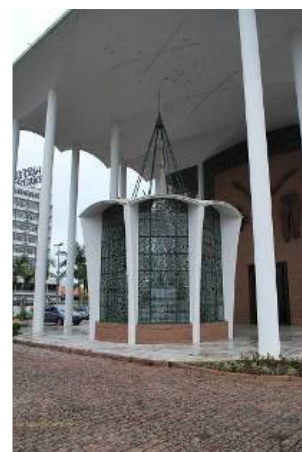
Fig. 3.97 – Vista do batistério Fonte: Do autor
