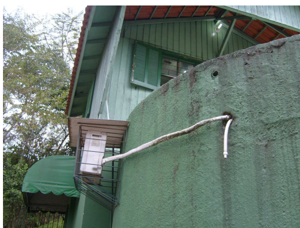
Figuras 9 e 10 - Fotos da fachada exterior do estúdio da banda Dazaranha construído dentro da antiga caixa d'água da Vila Ivan Mattos, nos fundos de cemitério do Itacorubi. Foto de Guilherme de Castro, realizada em 17.08.2009.
