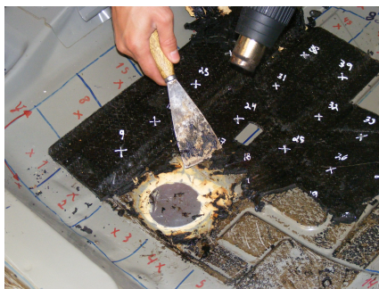
Figura 4.12: Procedimento de retirada da Manta Asfáltica da carroceria.
