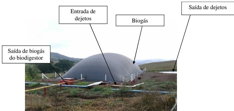
**Figura 7** – Foto do Biodigestor utilizado na granja de suínos no município de Iomerê /SC.
