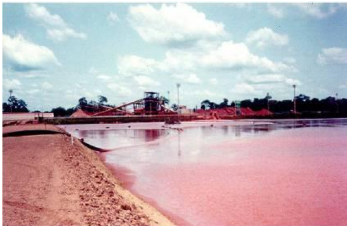
Figura 4 – Lagoa de deposição do resíduo lama vermelha
